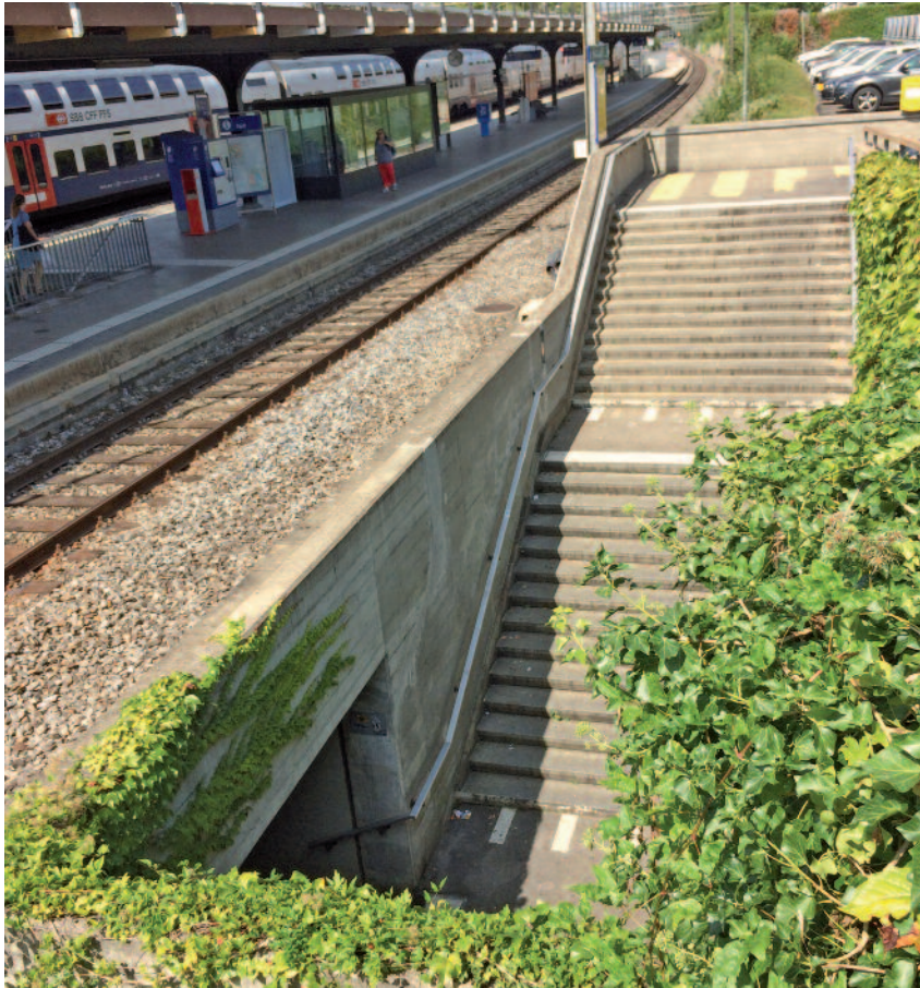
Abb. 1: Bestehender bergseitiger Zugang in die Personenunterführung
