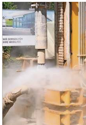
250 Meter tief wurde gebohrt.
