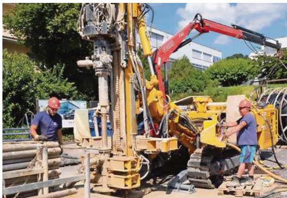
Im August führen auf dem Parkplatz Baumaschinen auf.
