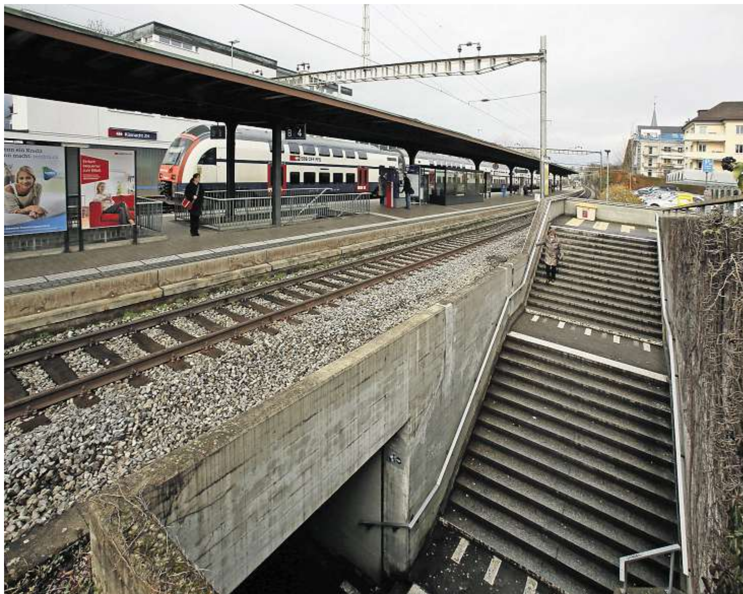
In der Mitte des Perrons befinden sich derzeit nur Treppen. Ob mit dem Parkdeck eine bergseitige Rampe möglich wäre, ist noch unklar.
