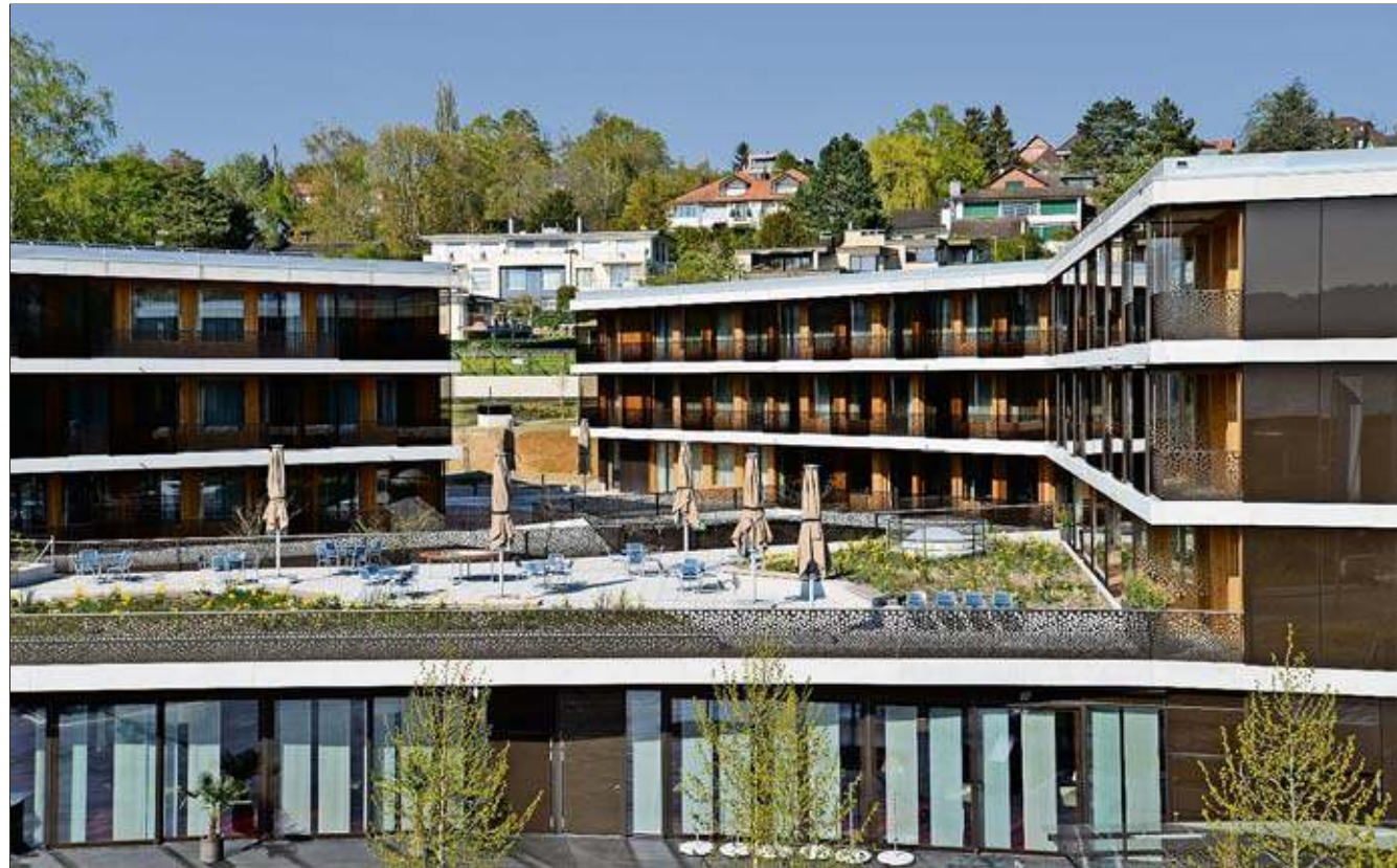
Dieses Bild vom neuen Alters- und Gesundheitszentrum wurde im April von einer Hebebühne aus aufgenommen.
