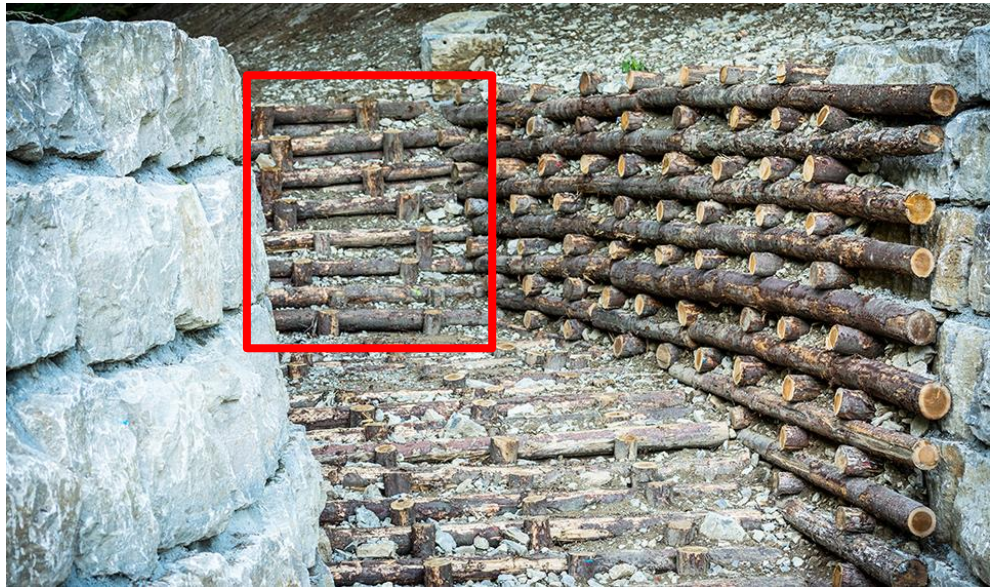
Abbildung 21: Naturnaher Ausbau als temporäre Baugrubensicherung mit horizontalen und vertikalen Holzpflocken, Quelle Bild: Naturmaher Ausbau von zwei Klingen in Forchtenberg (i-mo-ti-on.de)
