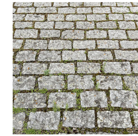
Parkfelder mit sickerfähigem Belag Granit Bindersteine 12, offene Fugen
