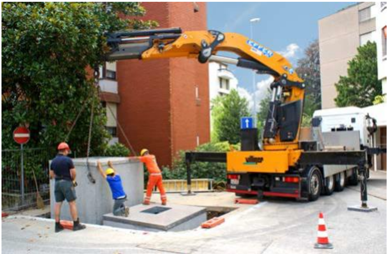
Abbildung 3: Foto einer Versetzung von Unterflur-Anlagen mit Villiger LKW
