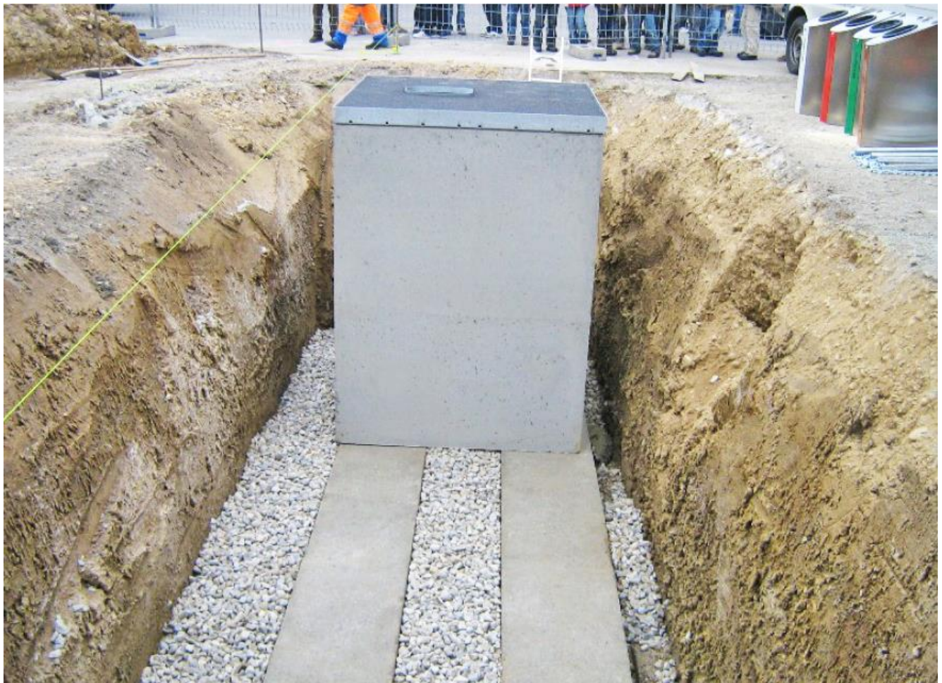
Abbildung 4: Foto eines Streifenfundaments
