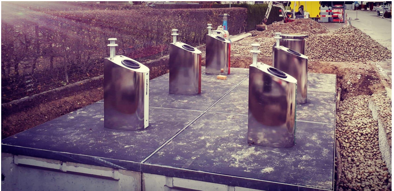
Abbildung 6: Beispielbild einer hinterfüllten Anlage
